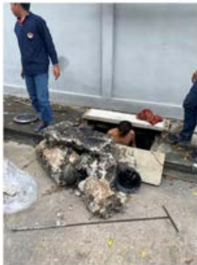
ตัวอย่างการลอกท่อระบายน้ำตามชุมชน
