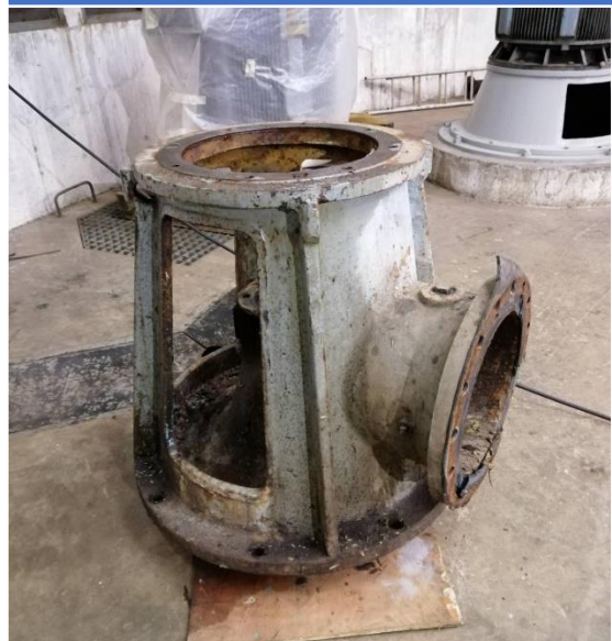
งานถอดรื้อถอดเครื่องสูบน้ำชุดที่ 6(ของเดิม))
