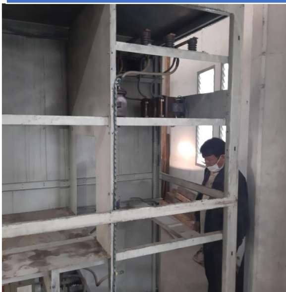
งานถอดรื้อถอดเครื่องสูบน้ำชุดที่ 6(ของเดิม)
