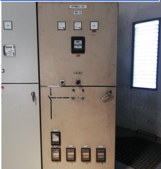
งานถอดรื้ออุปกรณ์ชุดควบคุมเครื่องสูบน้ำชุดที่ 6(ของเดิม)
